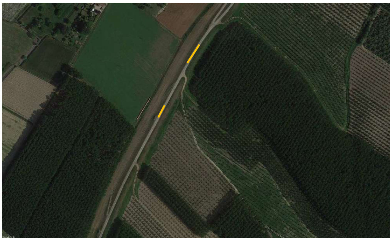
Argine Villastrada Dosolo – tratto 3
