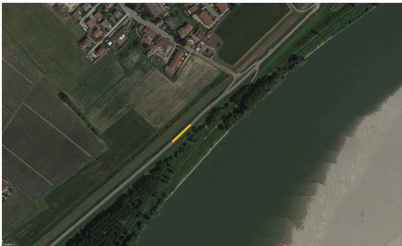
Argine Dosolo – zona quartiere Certosa
