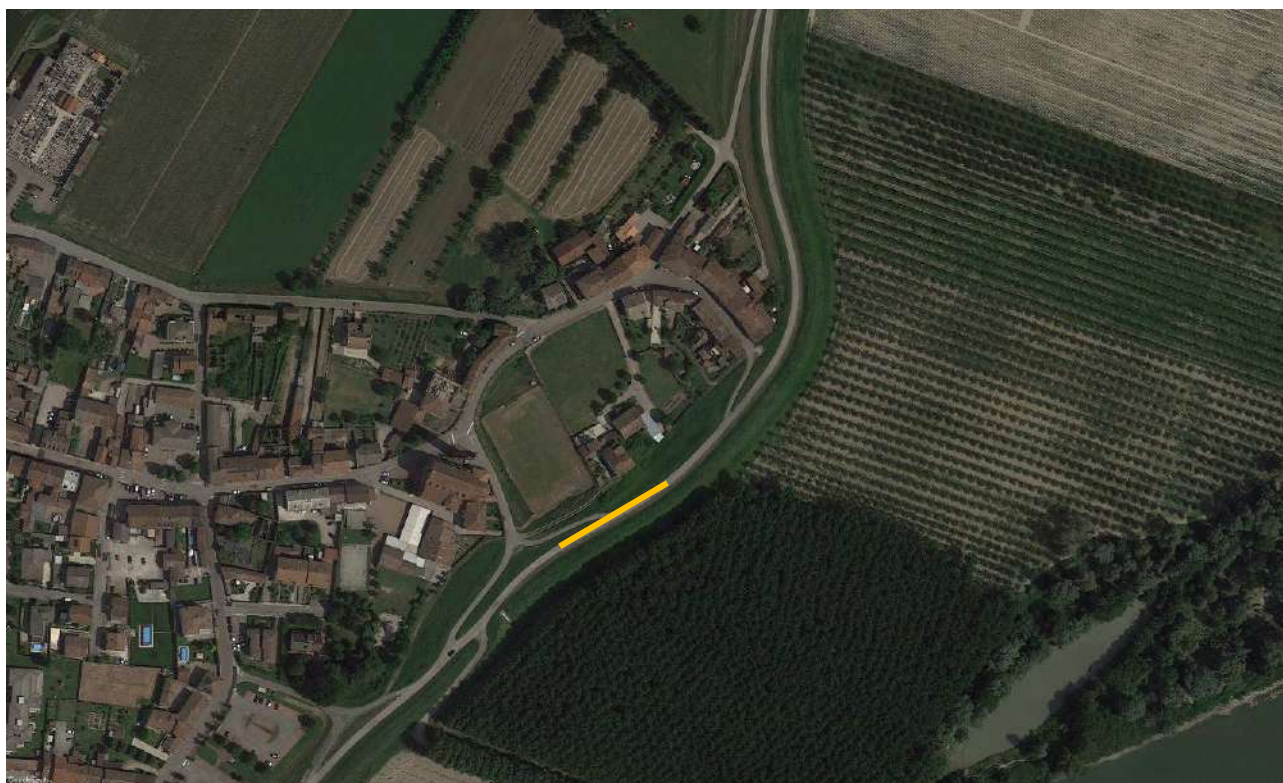
Argine Dosolo – zona Piazza castello
