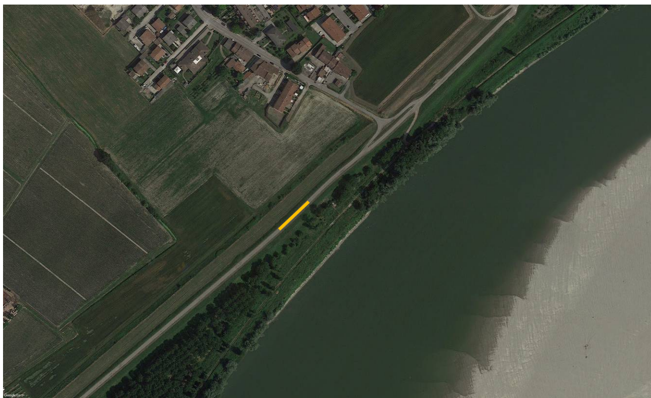
Argine Dosolo – zona quartiere Certosa
